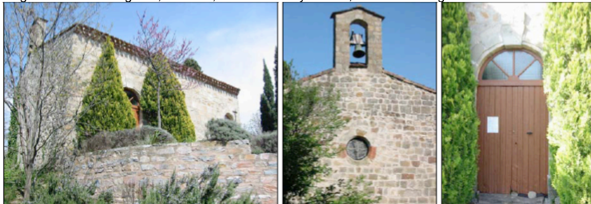
Elévations ouest (surmontée d'un clocheton) et sud (porte d'entrée).
