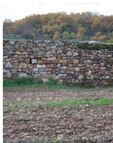
l'édification de terrasses
