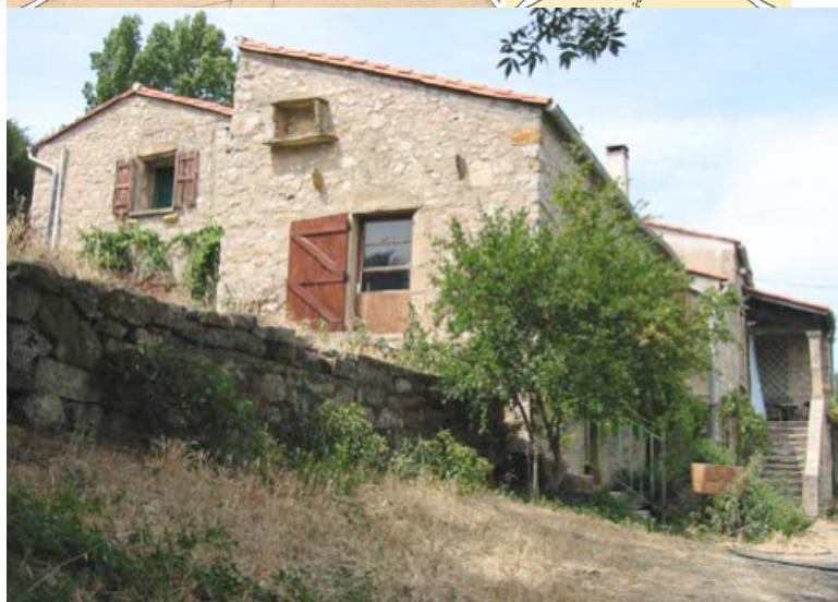
vue du bâtiment A
