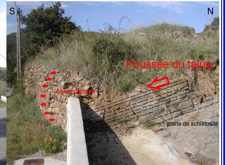
Muret déformé par la poussée
