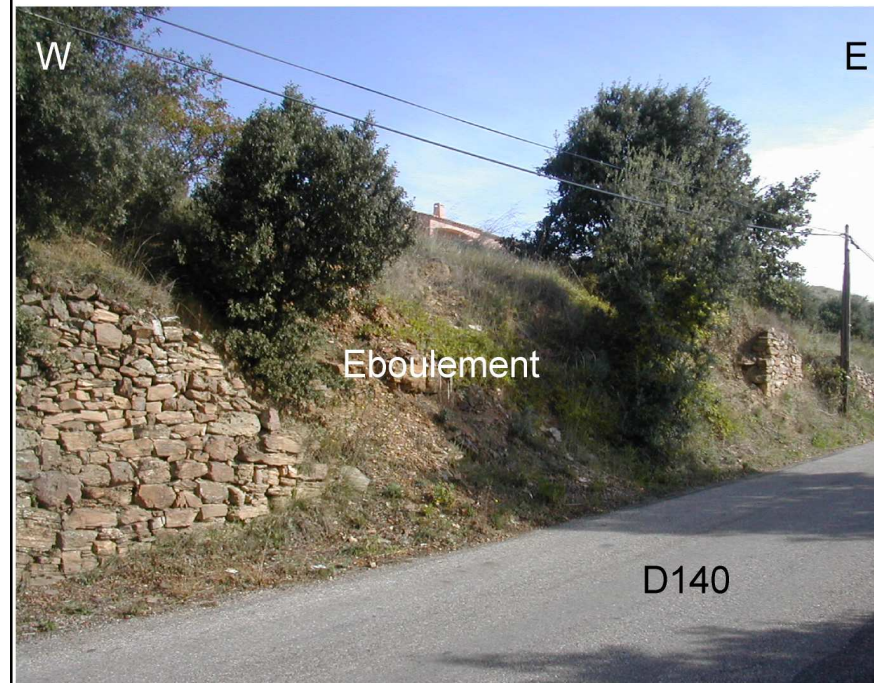
Portion de talus éboulée en bordure de la D140
