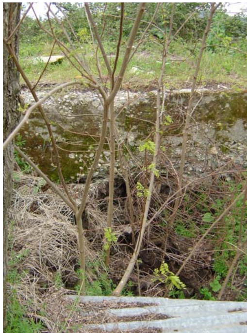
Photographie 9 : Puits Chazel, excavation sous la dalle
