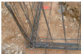
Nœud de chaînage - Continuité mécanique
