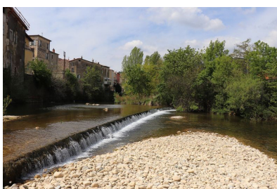
Seuil du Boulodrome avant travaux
