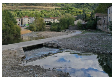
Seuil du Boulodrome après travaux
