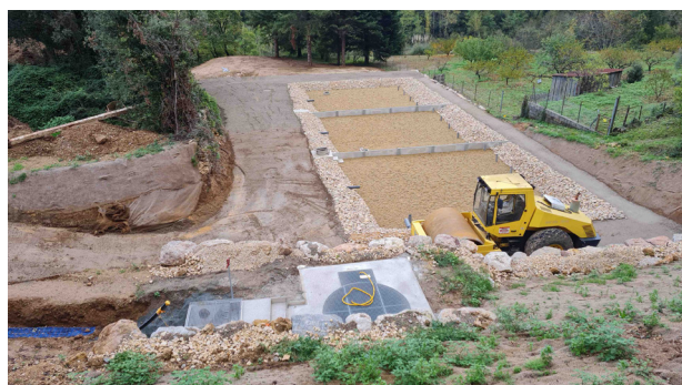
Travaux Step madières
