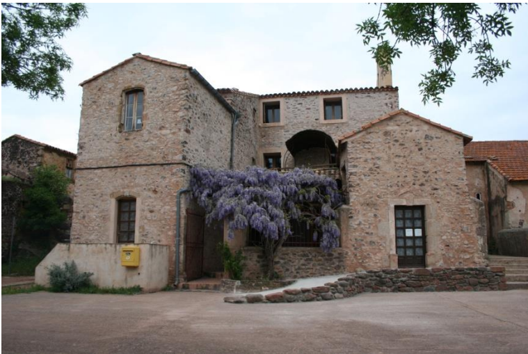
Photographie 3 : La Mairie et les deux logements communaux à l'étage
