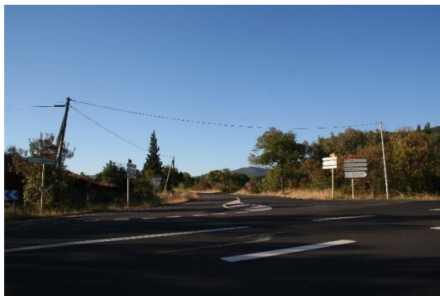
Photographie 54 : Jonction entre RD148 et RD148E5
