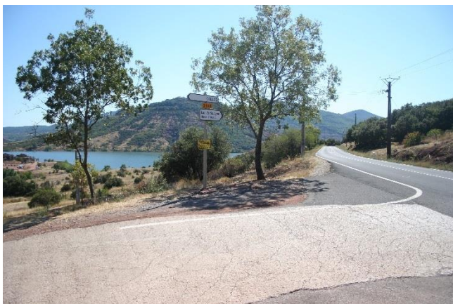
Photographie 57 : Jonction entre RD148 et chemin de desserte du village
