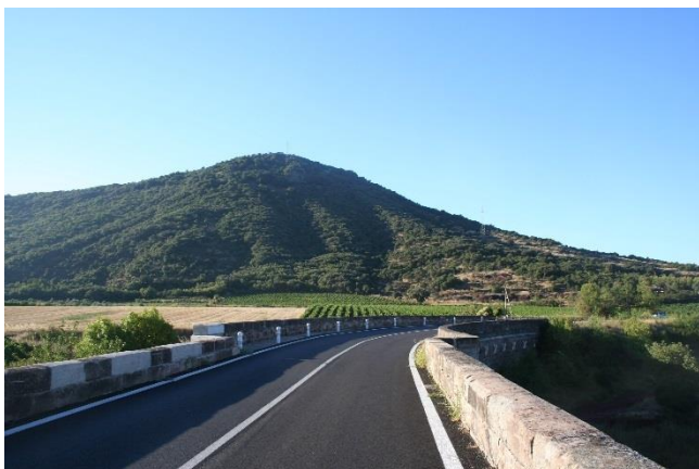
Photographie 53 : RD148 lors de son passage au-dessus de la Lergue en allant à Celles
