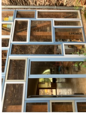
Exemple de façade en double vitrage de réemploi
