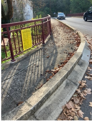
1 - Entrée Nord de Lodève.
