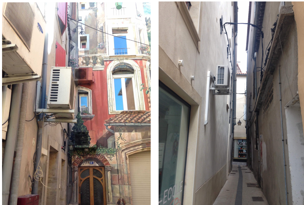
Photos de façade avec traitement technique et thermique inadapté
