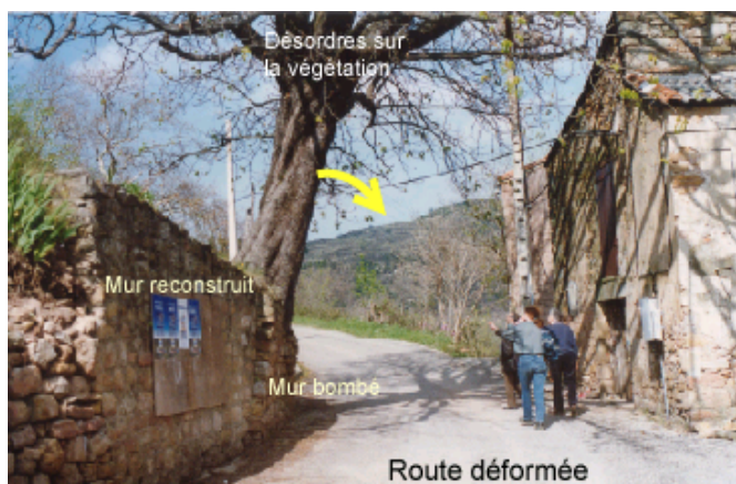
Figure 3 : Glissement de versant de Villeucun : désordres observables sur les bâtisses du hameau de Villeucun (toiture incurvée, mur bombé et mur fissuré)
