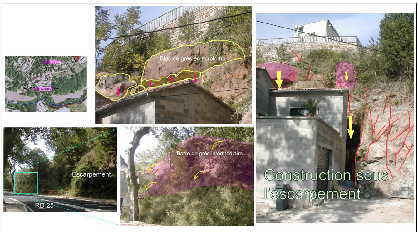
**Figure 3** : Eboulement et chute de blocs depuis la barre de grès médian (Trias) : site de la RD25, Centre bourg (entrée village le Haut).
