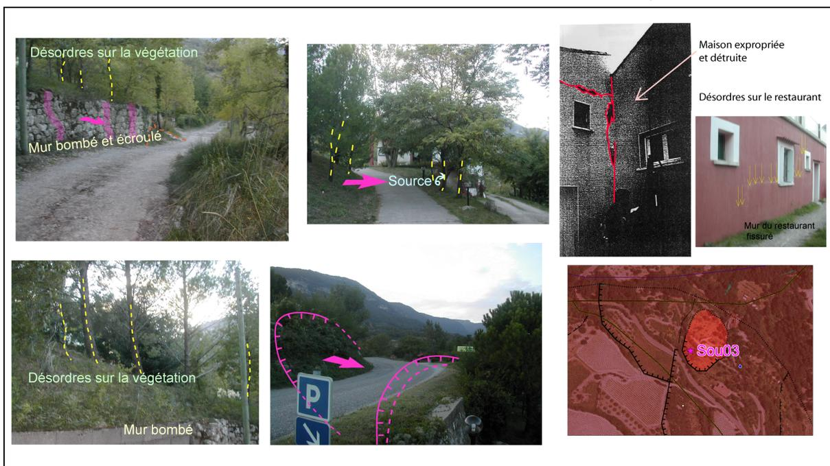
**Figure 8 :** Glissements de versant en rive droite de la Lergue : Désordres au niveau du lieu dit "Le Rial" (réactivation importante en 1993).
